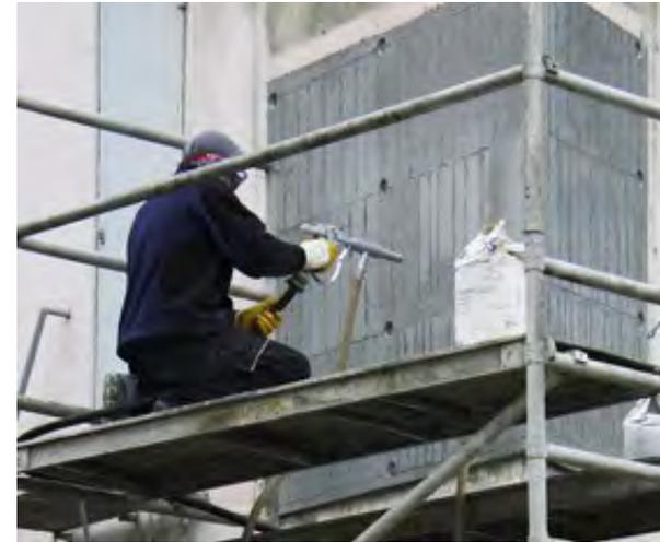
Abb.: Erstellung der Musterflächen am Turm und späteres Bearbeiten mit Sandstrahler
